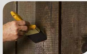
3. Nur bei Nadelholz im Außenbereich: Imprägnieren Sie das bearbeitete Holz mit Cetol Aktiva<sup>BP</sup>.
