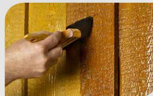
7. Die Beschichtung wird anschließend mit Cetol Novatech im ursprünglichen Lasurfarbton noch einmal überarbeitet, um die vorherige Tiefenwirkung einer lasierten Fläche zu erzielen.
