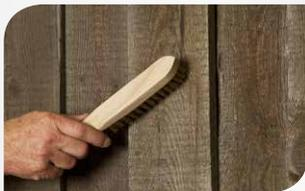
1. Entfernen Sie lose Altbeschichtungen und Holzteilchen mit einer Messing-Drahtbürste.
